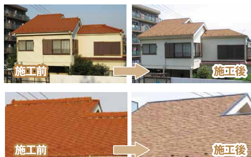
重たい瓦屋根から、軽量で耐久性に優れ、見た目も美しいオークリッジプロ屋根材へと葺き替えました。
