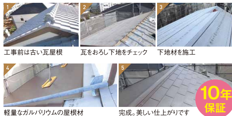
軽量のガルバリウムの屋根材 完成。美しい仕上がります
